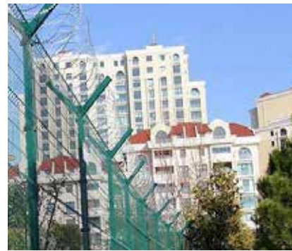
V aparat üzerine helezon jiletli tel uygulama
