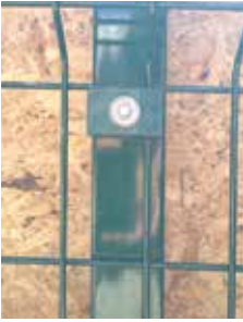
Çakma klipsli montaj sistemi
