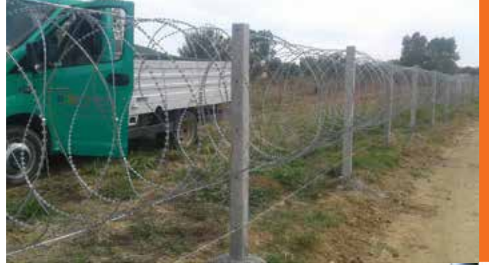
Düz beton direk jiletli tel uygulama
