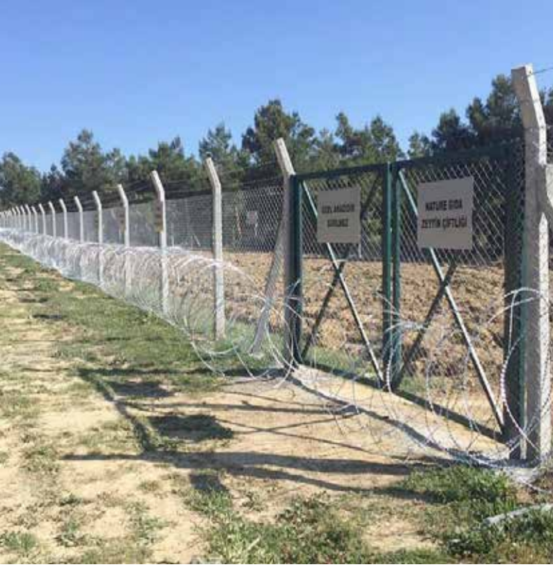
Boyunlu beton direk ve 90'lık helezon jiletli tel uygulama
